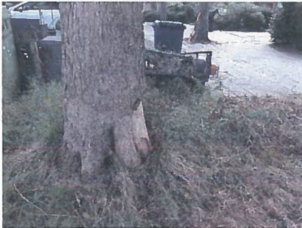
Foto 20: stamvoetschade en -holte bij boom 092483
