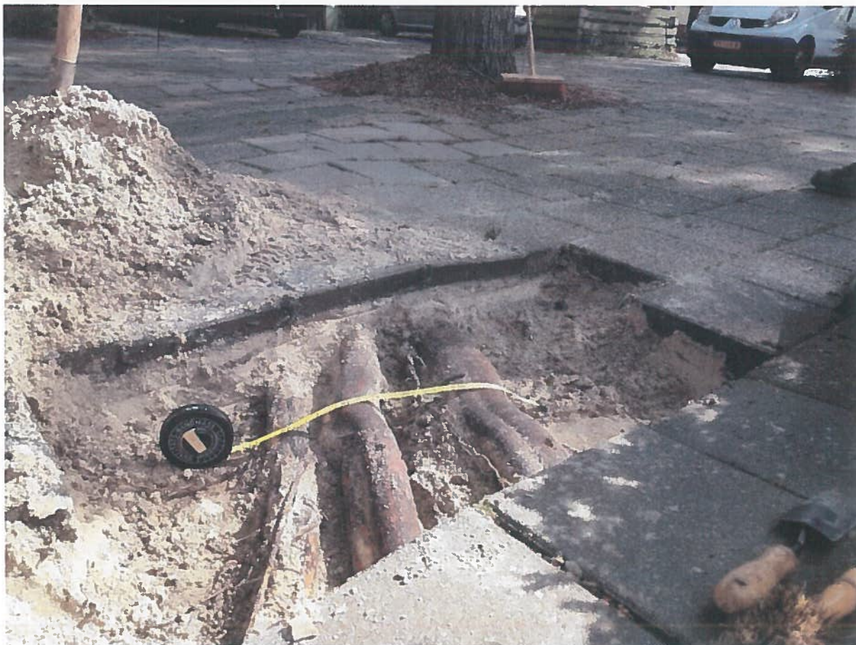
Foto 9: beworteling in proefseuf 1 (t.h.v. boom 092480)
