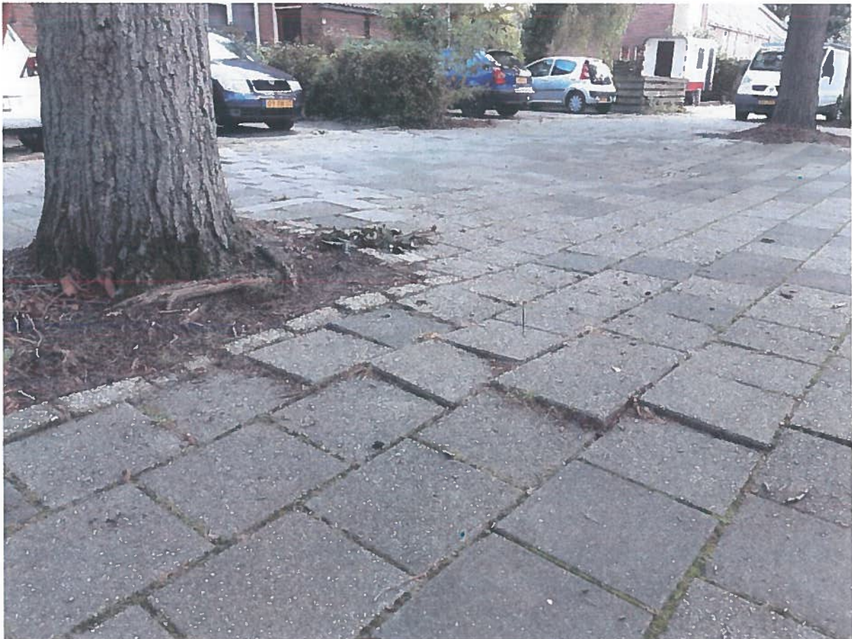
Foto 1: beeld van de groeiplaats van boom 092479 en 092480 (incl. wurgwortel en golvende tegelverharding als gevolg van wortelopdruk)
