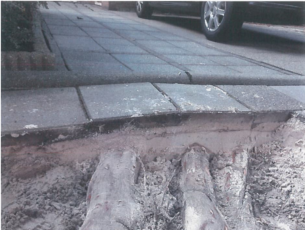
Foto 8: beworteling in proefseuf 1 (t.h.v. boom 092480)
