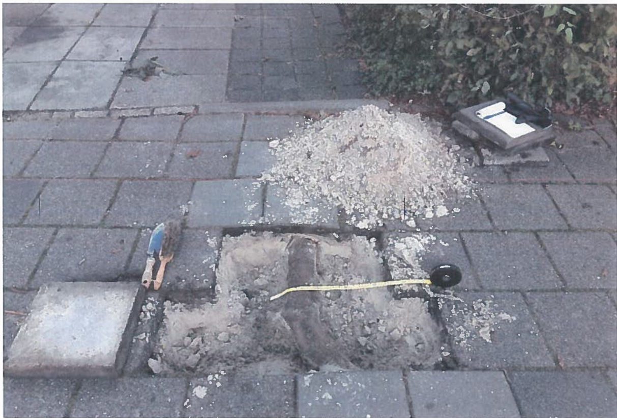
Foto 17: beworteling in proefseuf 4 (t.h.v. boom 092480)
