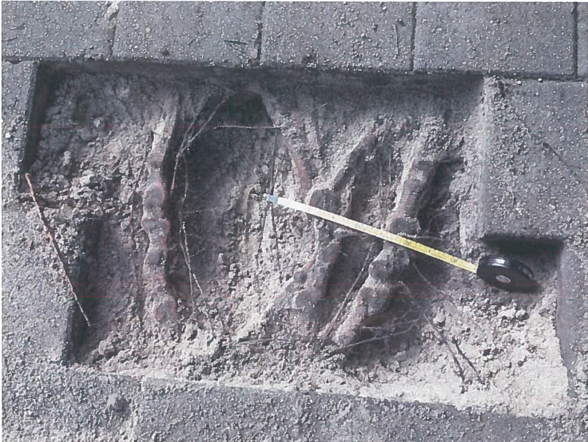
Foto 15: afgeplatte beworteling in proefseuf 3 (t.h.v. boom 092479)
