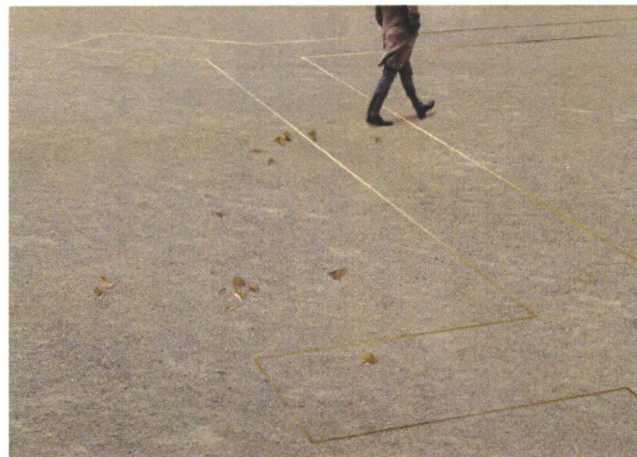
SUBTIEL DUNNE MESSING STRIP IN DE HALFVERHARDING MAAKT DE CONTOUREN VAN DE VROEGERE BUITENMUREN ZICHTBAAR
