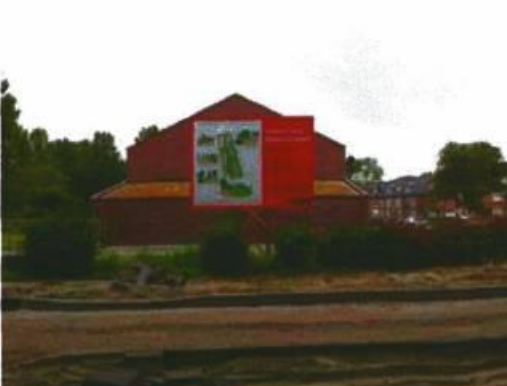
Bessemoerpark in uitvoering
