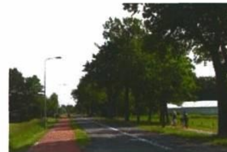
Paterswoldseweg: te weinig ruimte in profiel
